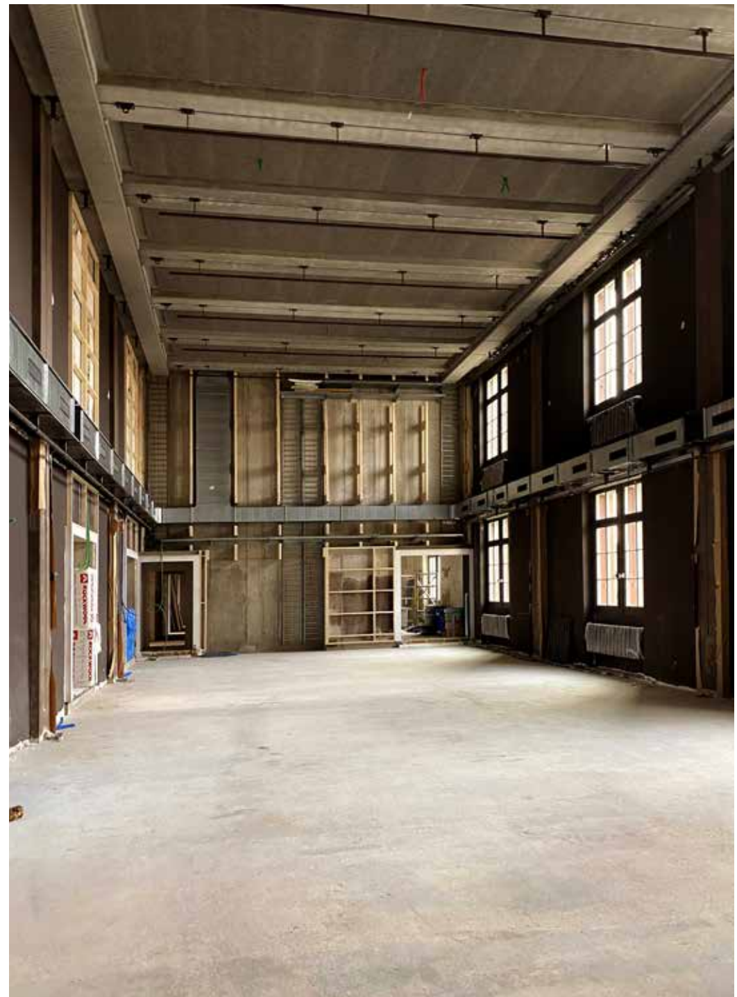
Baustelle März 2021- Saal
