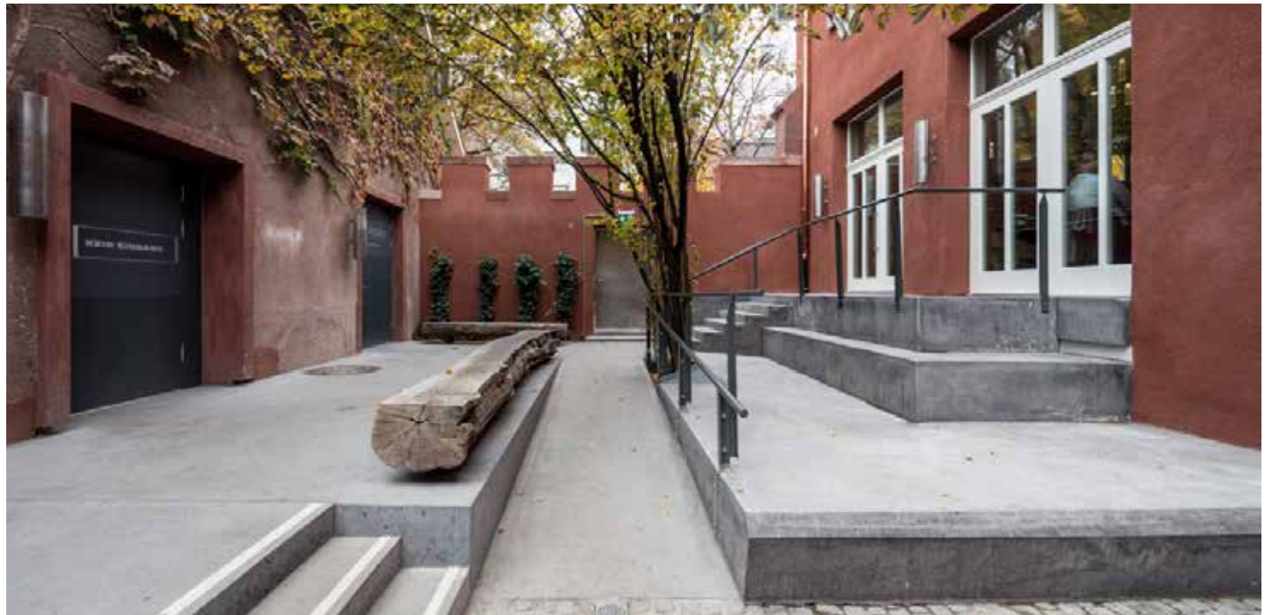
Um den unterschiedlichen Höhen der Gebäude gerecht zu werden, führte FDR Studio eine funktionale und gleichzeitig ästhetische Betontopographie ein
