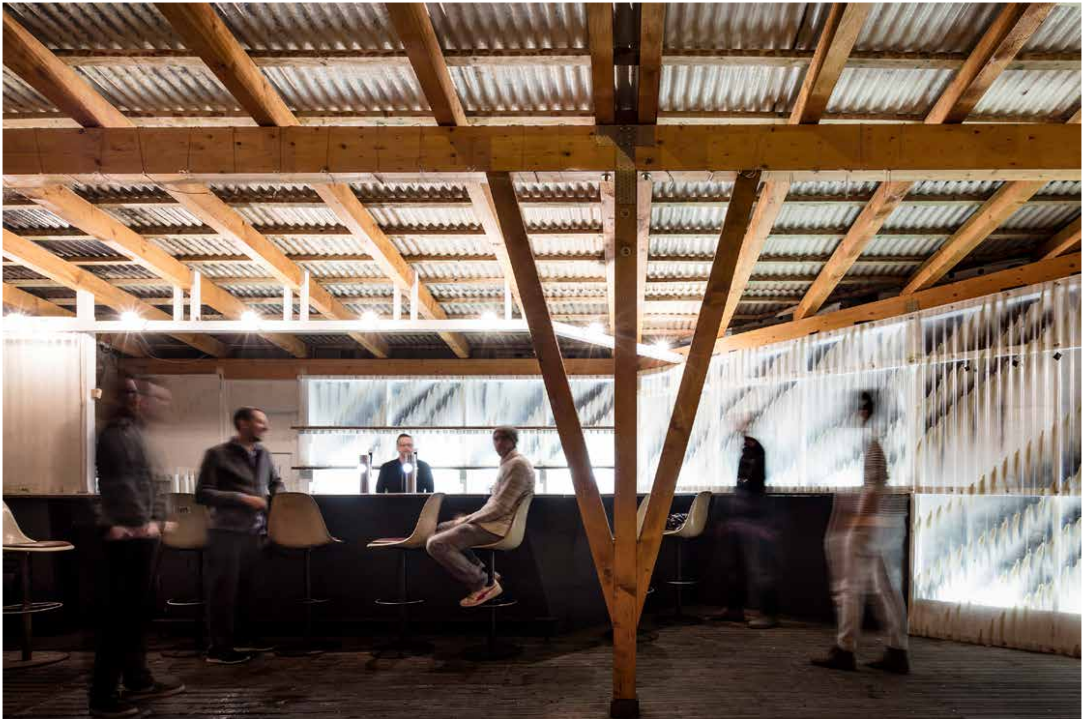
Die Aussenbar ist mit mobilen Paneelen aus Wellpolyesterplatten ganz abschliessbar
