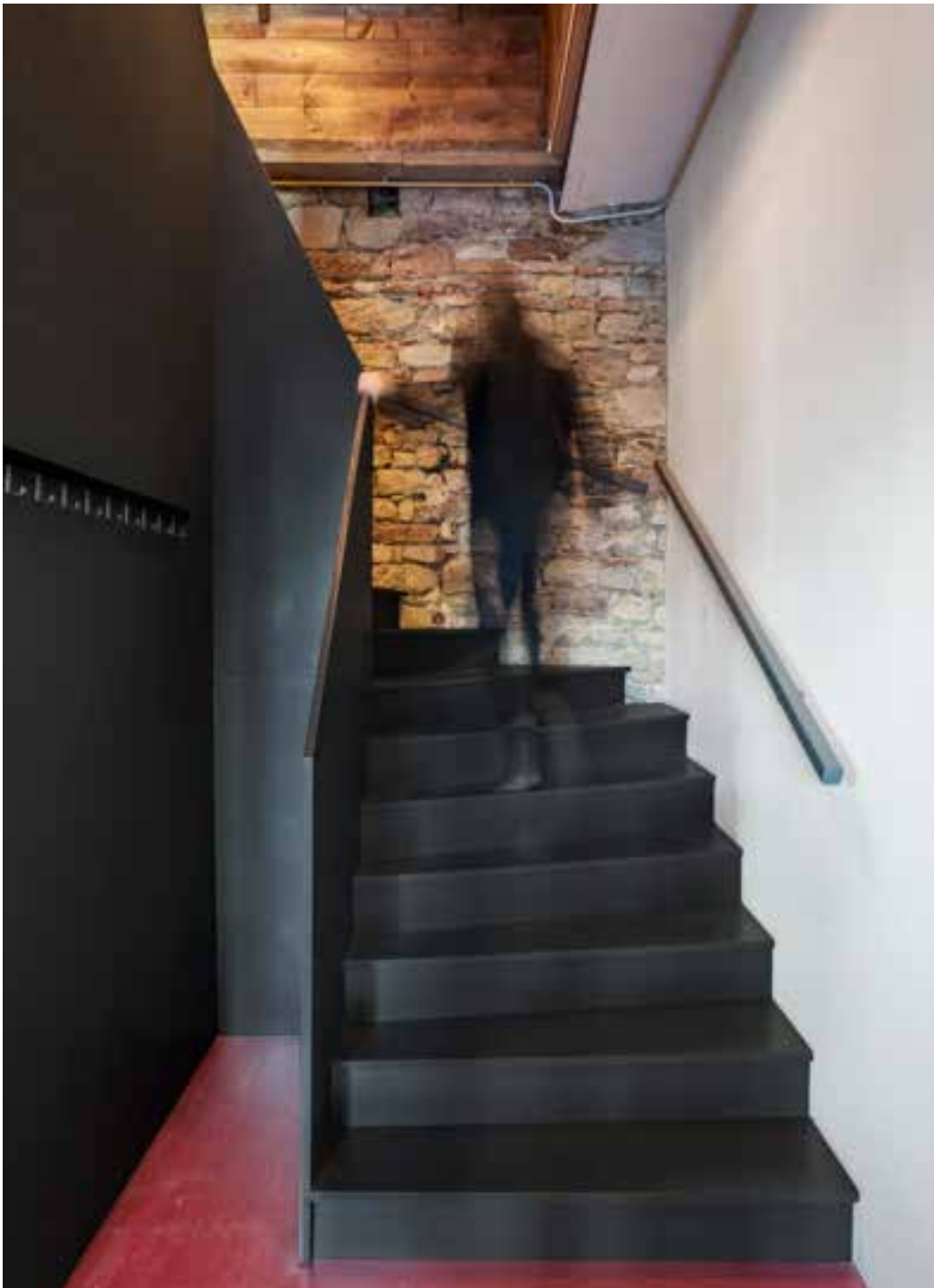
Die Treppe ist aus MDF und wurde so konzipiert, dass der Bauherr diese selbst bauen konnte.
