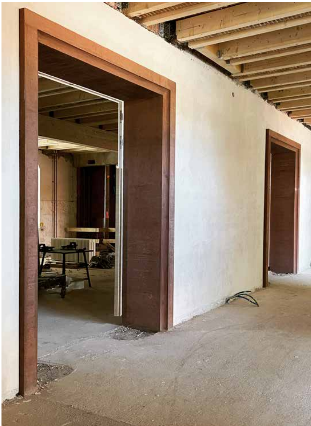
Baustelle März 2020- Gewände aus eingefarbten Beton
