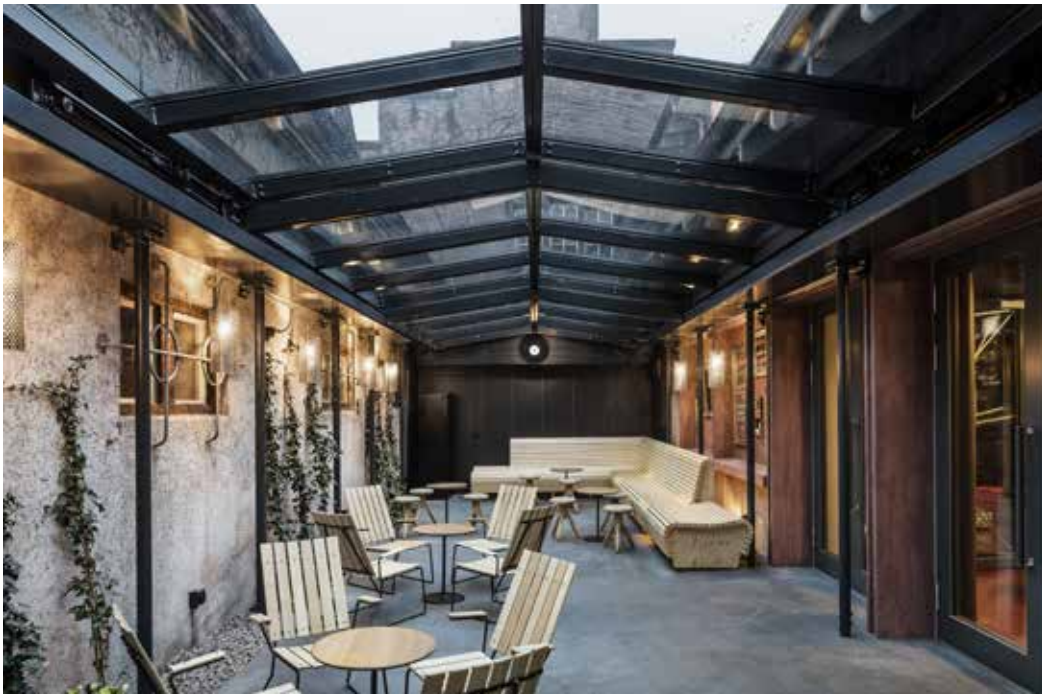
Das Dach vom Fumoir kann ganz geöffnet werden
